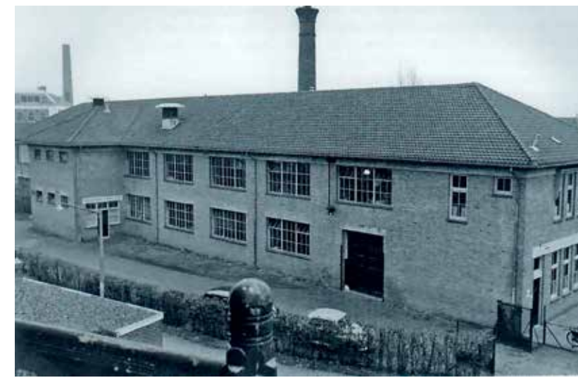
Het pand aan de Professor Van Vlotenweg, waar Gottmer van 1950 tot 2002 was gevestigd.
