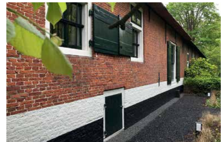
Boven: de topgevel met de zogeheten schuine strek of (boeren) vlechtingen in het metselwerk. Onder: de geschilderde plint met halverwege een ventilatieluik van de onderliggende melkkelder.
